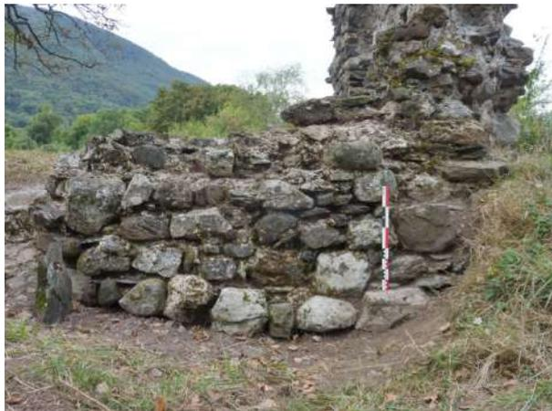
*Fig. 18 : Détail de l'élévation de MR01 avec ressaut de fondation*
