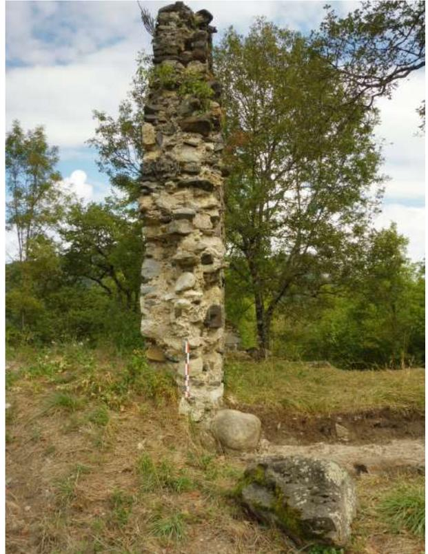
*Fig. 17 : Arrachage des chaînes d'angle entre MR03 et MR04*
