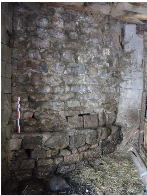
Fig. 15 : Vue du ressaut de fondation extérieur du mur MR01 dans la chèvrerie accolée au chevet de l'édifice
