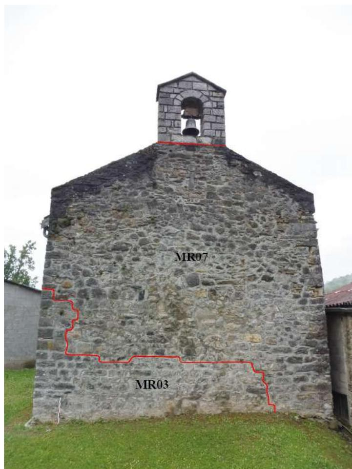
Fig. 14 : Détail des reprises de maçonnerie de la façade occidentale de l'édifice
